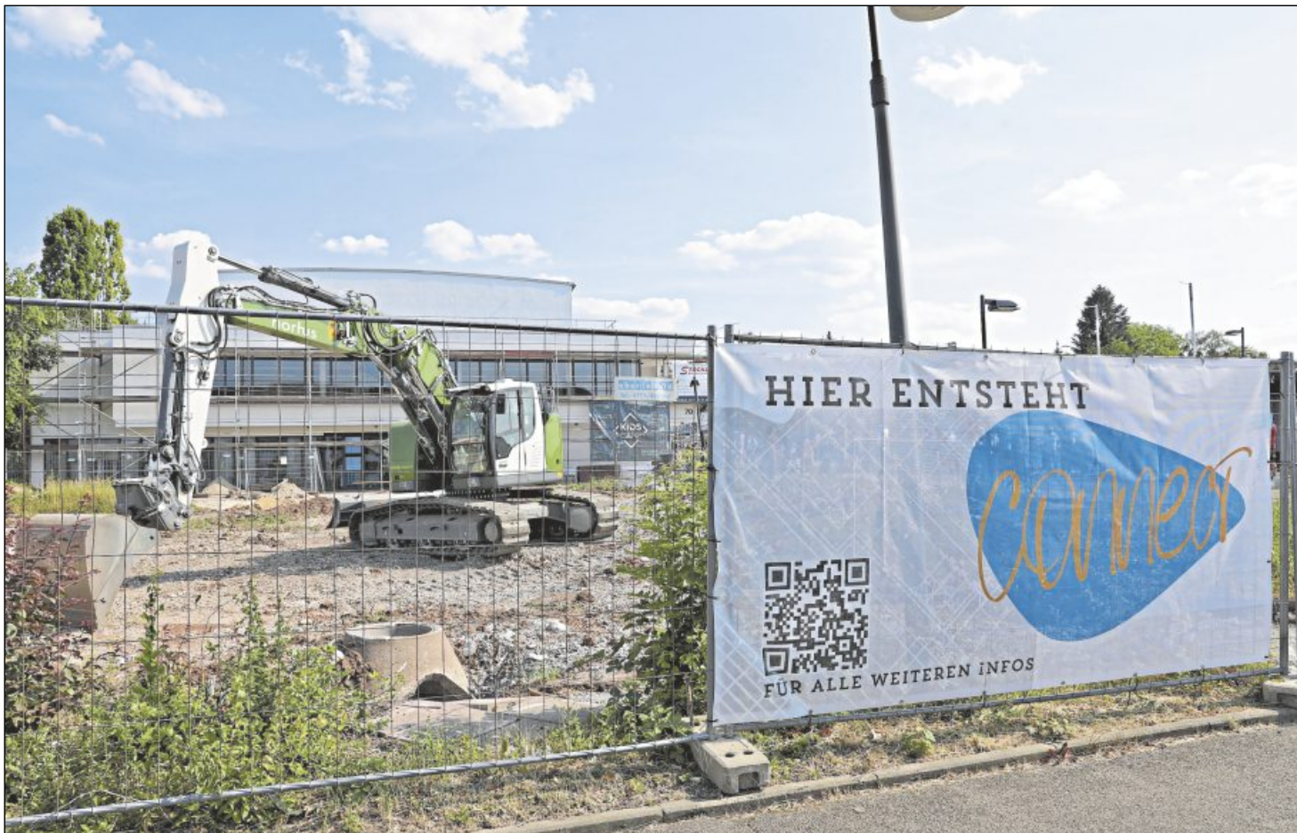
Der Startschuss für den Bau des neuen Begegnungszentrums der SV Schorndorf ist am Samstag mit dem Spatenstich gefallen.
