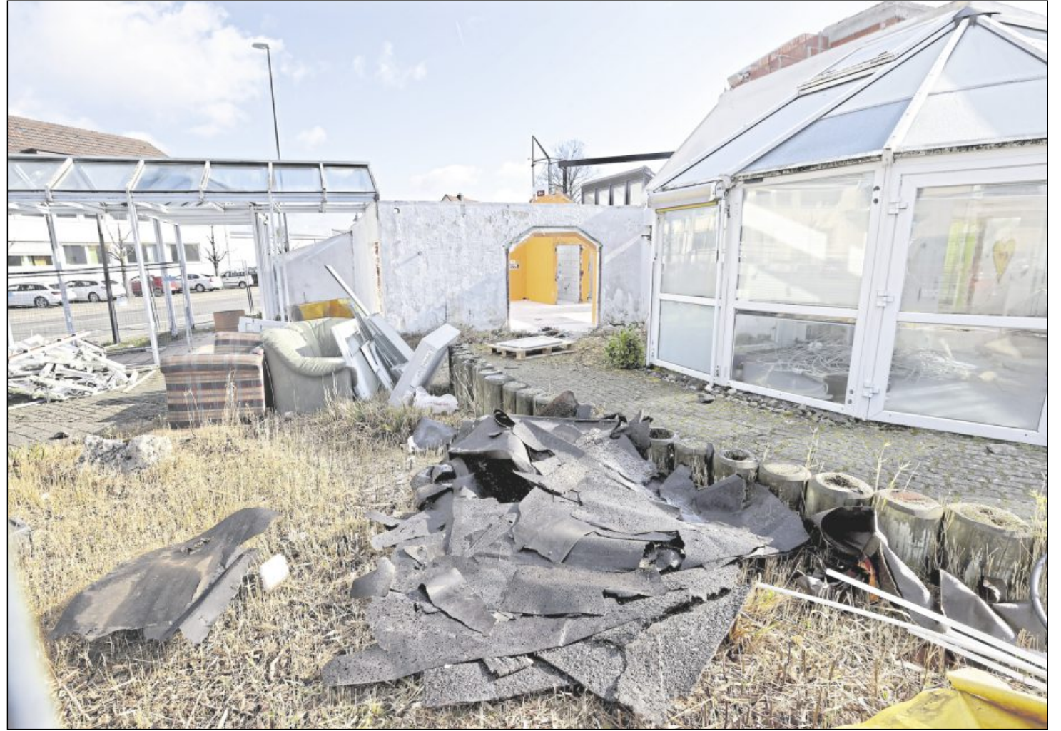
Jeden Samstag ist ein Bauteam der christlichen Gemeinde am Werk: Der Abriss der Wintergärten erfolgt in Eigenarbeit.
